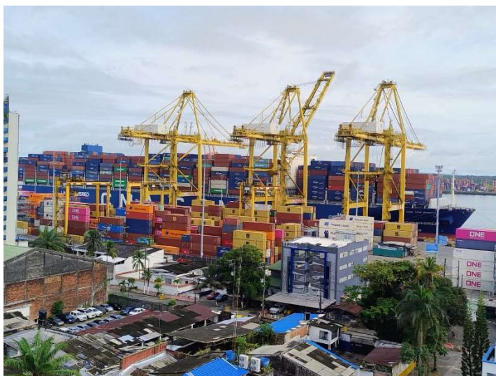
Figura 3. Foto de un barco dentro del Puerto de Buenaventura
